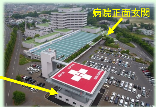
病院正面駐車場の西側にヘリポートがあり、その1階に会場となる会議室がございます。
